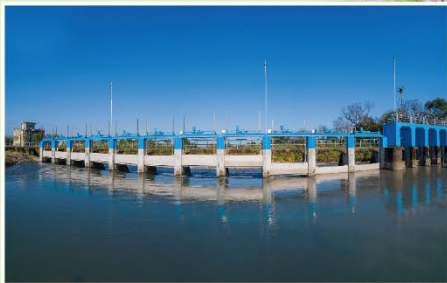
▲萬長春圳渠首工
