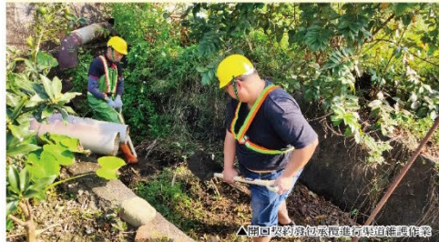
▲開口契約發包承攬進行渠道維護作業
