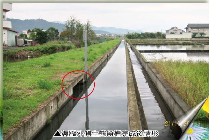
渠牆外側埋設生態pvc管情形
