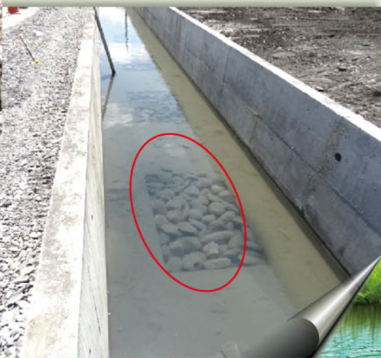
▼渠底切方孔施工情形
