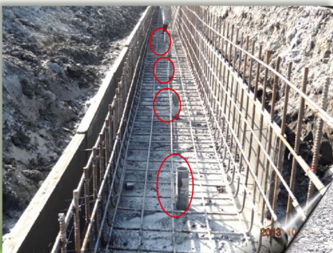
◀渠底埋設pvc管施工情形
