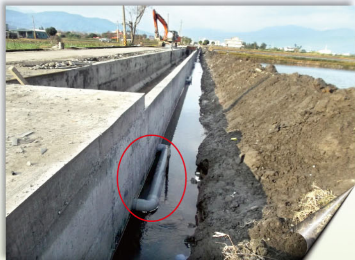
渠牆外側埋設生態pvc管情形
