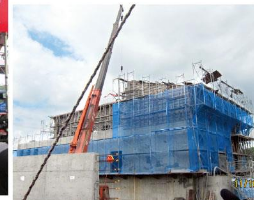
▲清水抽水站主體工程興建情形
