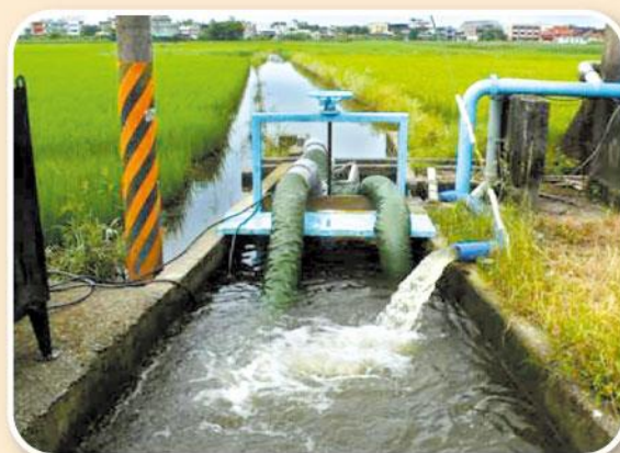
▲移動式抽水機運作情形
