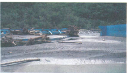
◎南澳第一幹線渠首工遭蘇拉颱風沖毀
