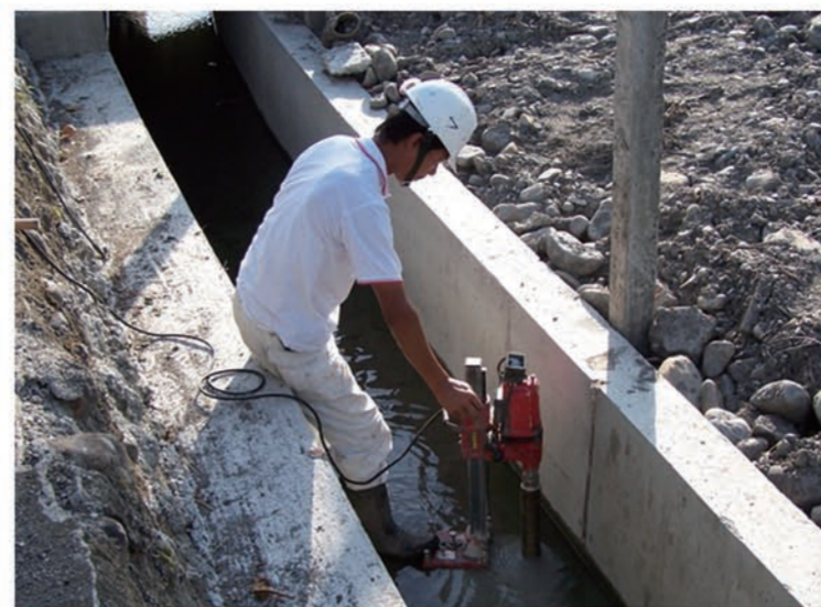
完工渠底進行混凝土抽驗
