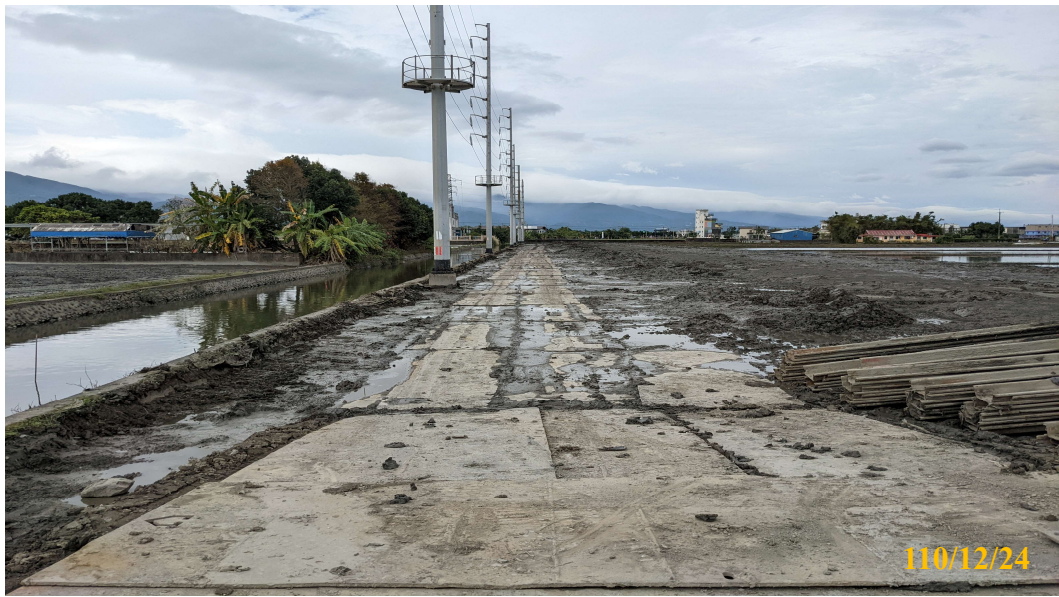
鋪設施工便道
