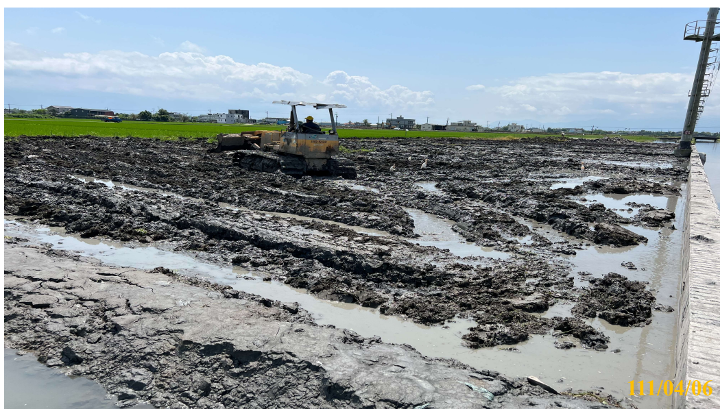
工程完工後恢復原地形地貌
