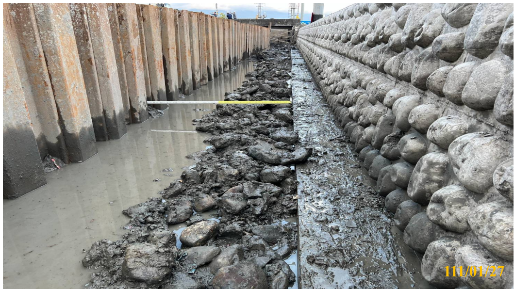
原有砌石打除再回填減少沖刷
