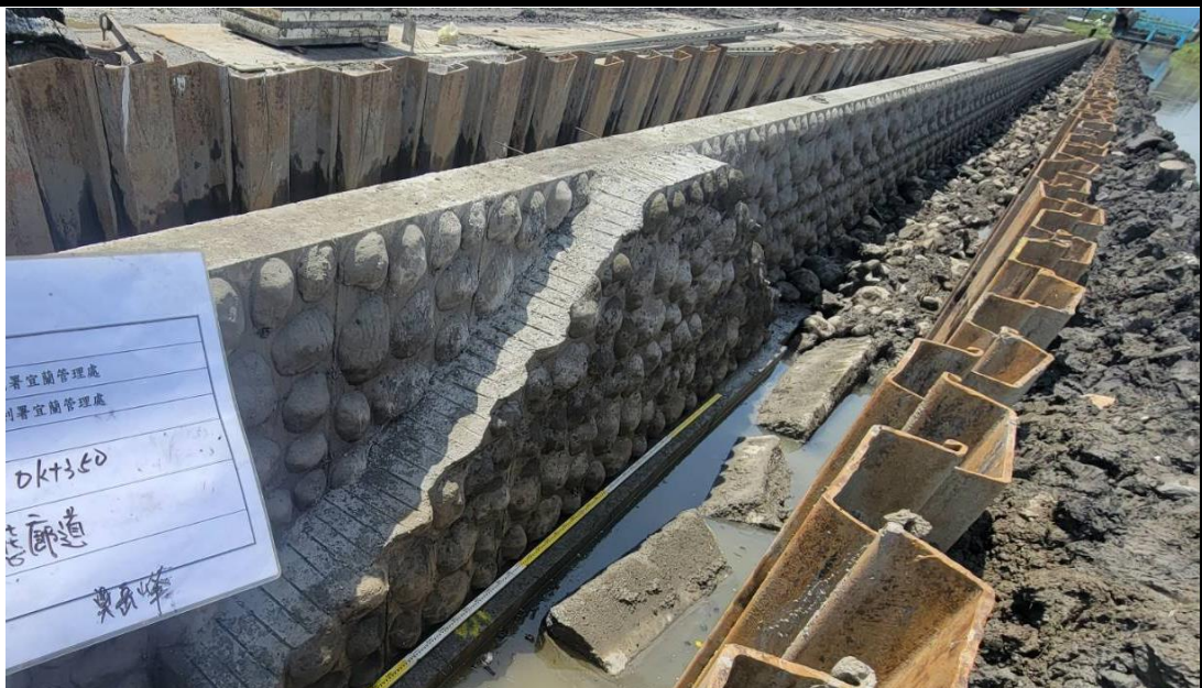
(基腳拋填原護岸塊石) 設置生態通道
