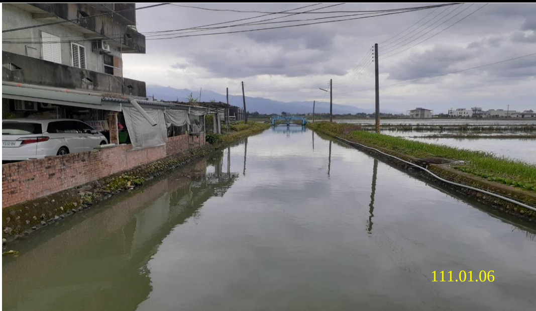
茅埔排水施工前
