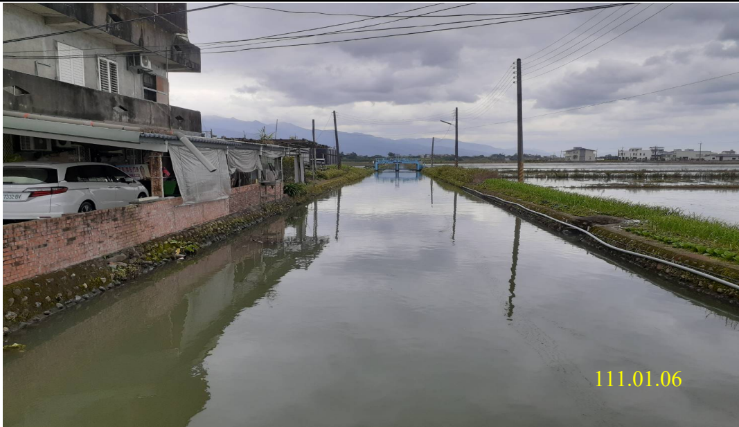
茅埔排水施工前
