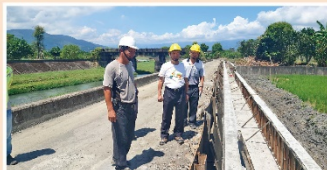
▲「安農三大義5-5小排等更新改善工程」臨時擋土設施打設狀況
