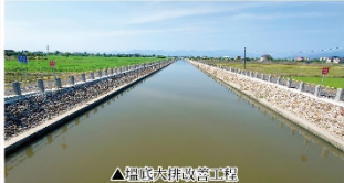
▲埤底大排改善工程
