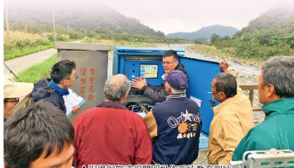
▲現場辦理通關開門排砂遙控教育訓練
