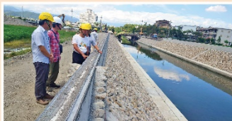
▲「砂仔港排水下游段(第2期)改善工程」施工情形
