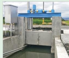
▲渡槽與排水橫交—改善後渡槽通水時
