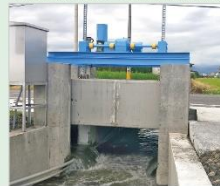
▲渡槽與排水橫交—改善後開閘時以供排水
