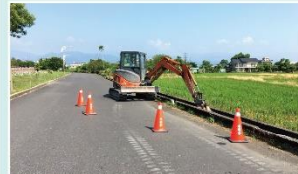
▲渠道清淤作業設立交通安全錐
