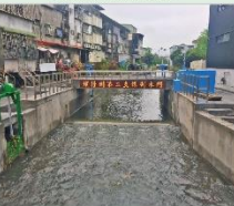
▲傾倒堰傾倒後排水
