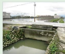
▲渡槽與排水橫交—改善前
