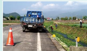
▲設立警示以保障人員作業安全
