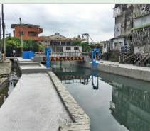
▲傾倒堰開閘後取水
