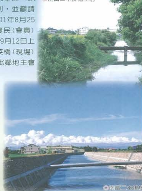
南富二中排施工前
