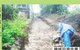
機械回填作業
