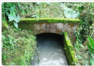
▼ 7號隧道，長度888公尺
