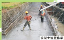
混凝土澆置作業
