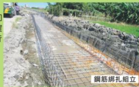
鋼筋綁扎組立
