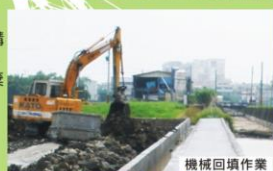
機械回填作業
