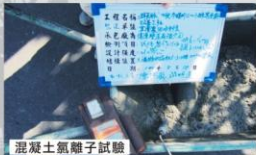
混凝土氯離子試驗
