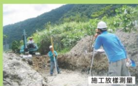
施工放樣測量
