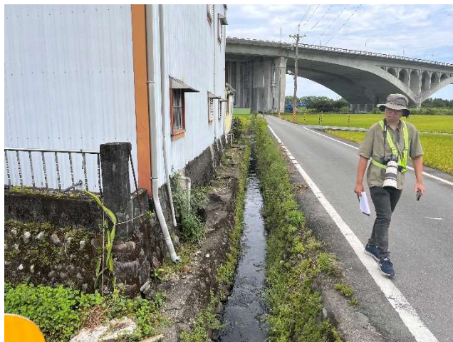
112 年 6 月 19 日在北富 2 工區現場勘查。
