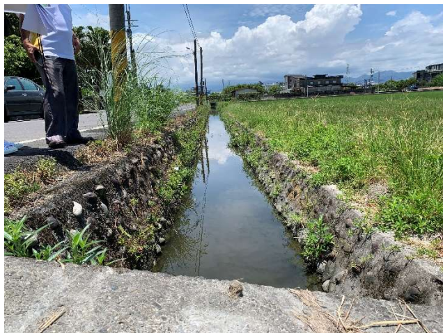
112 年 6 月 19 日在北富 6 工區現場勘查。
