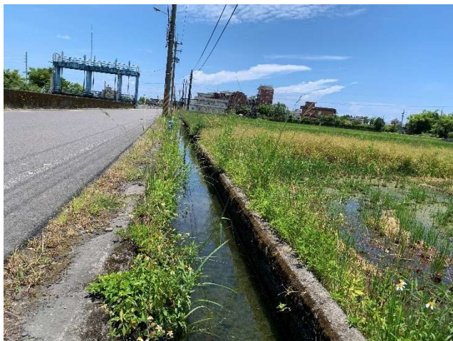
112 年 6 月 19 日在北富 5 工區水域現場勘查。
