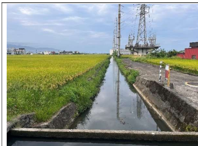
說明：第 2 期工程現有圳路情況(尚未施工) 112/06/19
