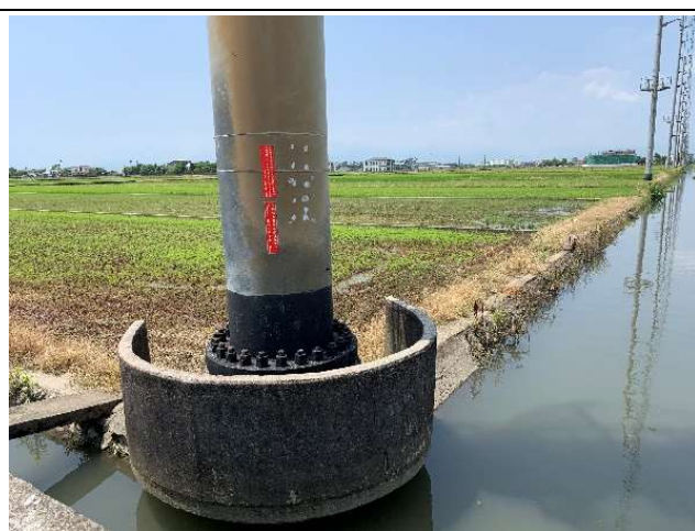
說明：第 1 期工程於工區中段拍攝之地標。 112/06/19
