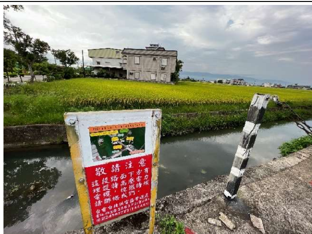
說明：工區部分路面下方有埋設高壓電纜。 112/06/19
