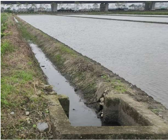
說明：宜壯 5 工區 宜壯新福支線 B-6 分線
