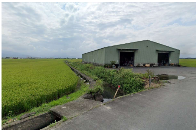
112 年 6 月 19 日隆恩排水工區現場勘查。
