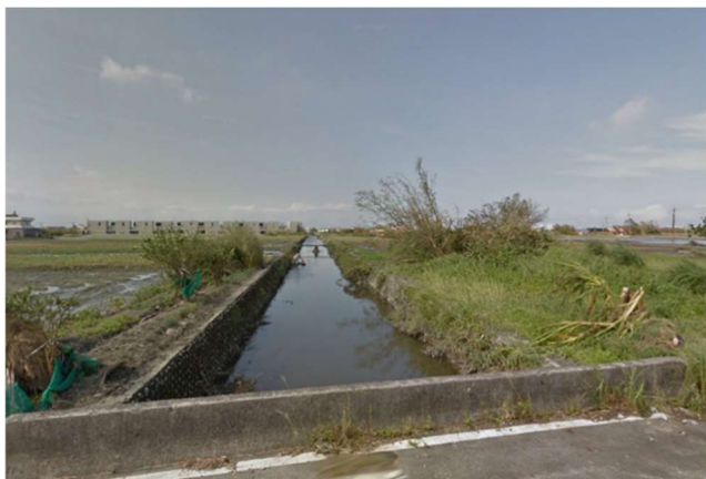
112 年 6 月 19 日於林和源工區水域現場勘查。
