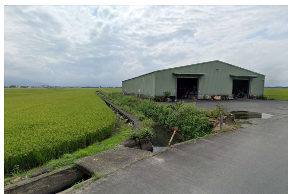
(隆恩)工區：隆恩排水
