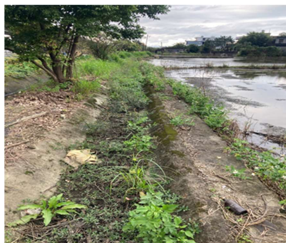
說明：南富 2 工區 南富六主給 6-6 小給
