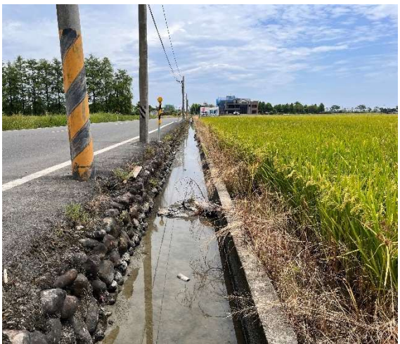
說明：南富7工區 南富9-1 小排
