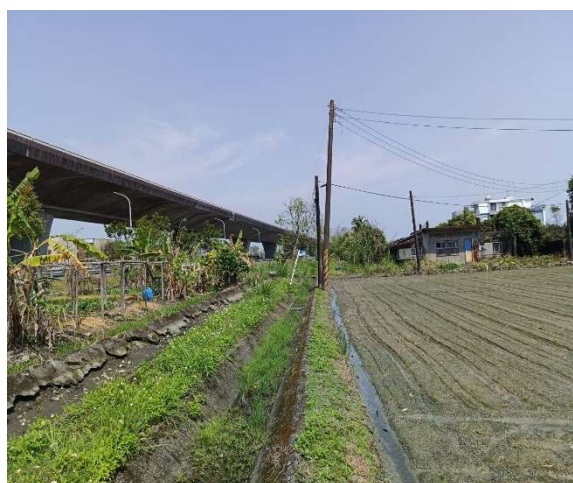
說明：南富 1 工區 南富六主給 6-1 小給
