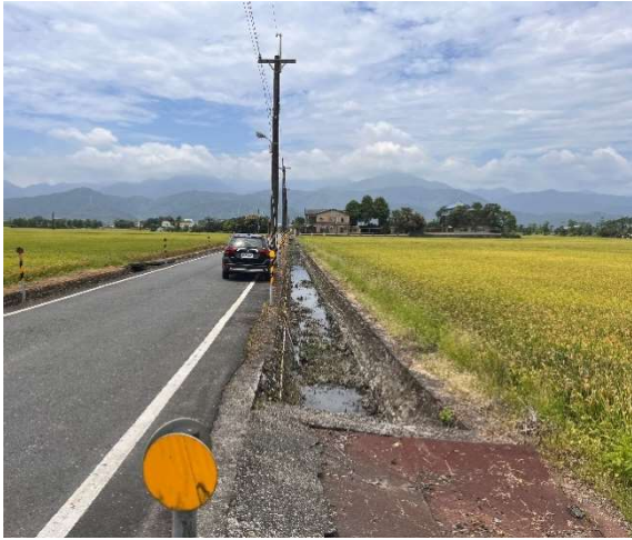
說明：南富 9 工區 南富十中排 11-3 小排
