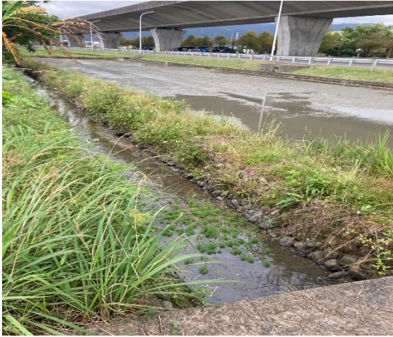
說明：南富3工區 南富三中排 5-6 小排
