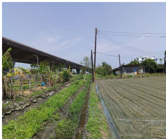
說明：南富 1 工區 南富六主給 6-1 小給
