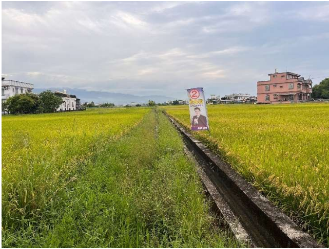
說明：淇武蘭 1 工區 塹底大排淇武蘭二中排 2-2 小排尚未施工現況。 攝於 112/06/19
