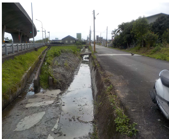
說明：礁溪 1 工區 淇武蘭一中排 1-5 小排
