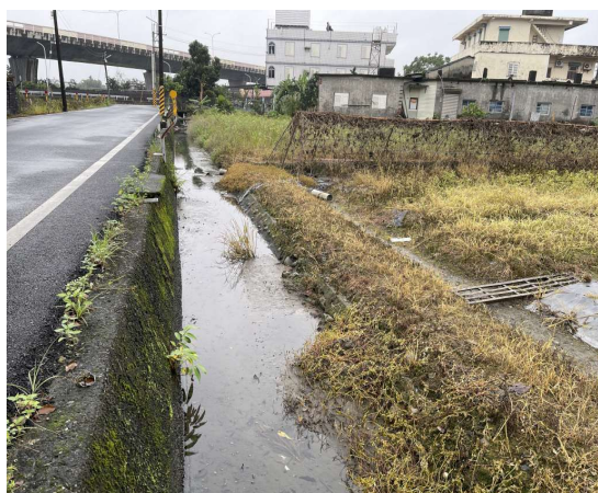
說明：礁溪 3 工區 淇武蘭一中排 1 補排
