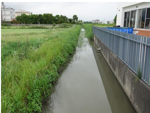
四結-04 工區：大埔排水協和 5-3 小排 (114 年 5 月 22 日)
