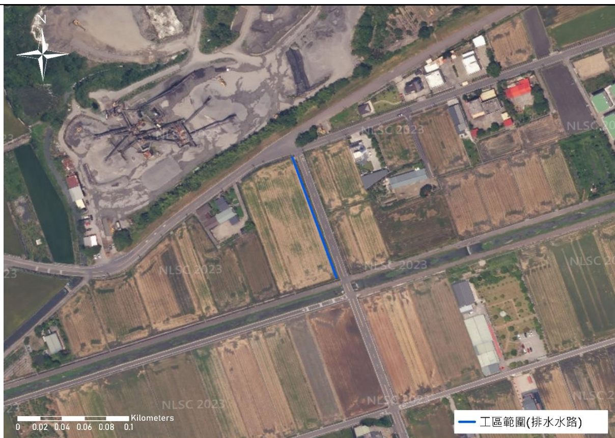
大洲-04 (中溪洲大排大洲中溪洲 6-9 小排)
