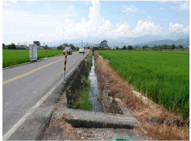
大洲-04：中溪洲大排大洲中溪洲 6-9 小排
