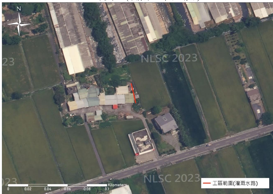
大洲-02 (中溪洲大排二分線大洲中溪洲 6-10 小給)
