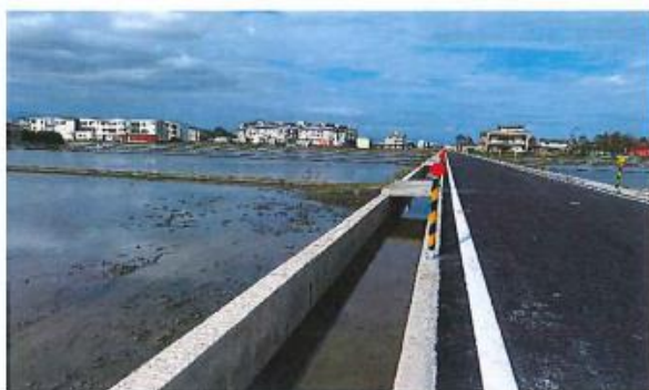
本案主體工程已全數施作完成
