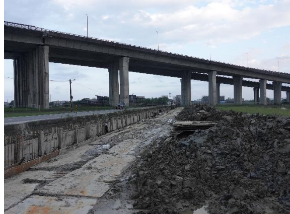
施作過程田側以堆疊臨時土坵作為工區與周邊環境之區隔界線。
