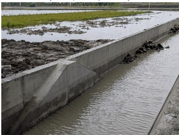
已施作兩處水泥式生態爬坡，但坡面刻紋尚未施作，延請廠商改善。 (115年1月08日)
