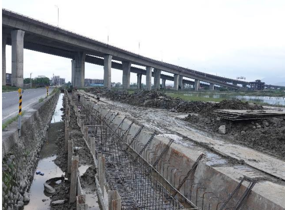
工程施作期間採半半施工維持上下游水流暢通，使水域生物有充分空間迴避。 (114年11月24日)
