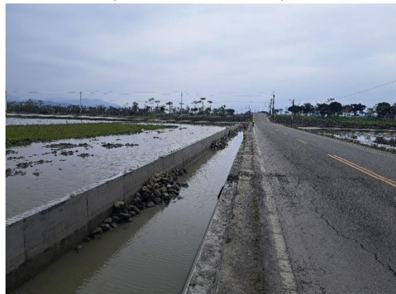
上游渠道主體已完工，田側堆疊之臨時土坵已移除，恢復棲地樣貌減少擾動。
