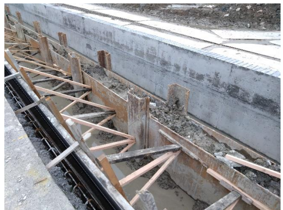
工程施作期間採半半施工維持上下游水流暢通，使水域生物有充分空間迴避。 (114年12月11日)
