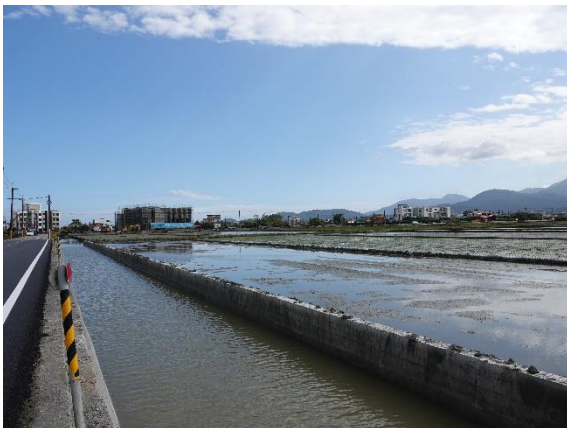
渠道主體已完工，田側堆疊之臨時土坵已移除，恢復棲地樣貌減少擾動，工區周邊已有不少涉禽棲息。(115 年 2 月 12 日)
