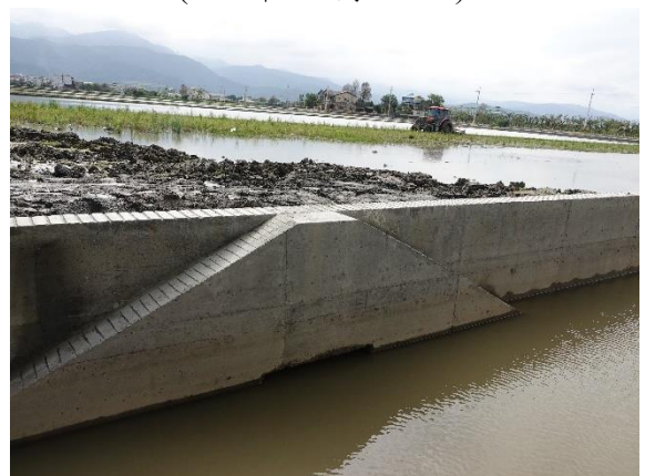
兩處水泥式生態爬坡及底部生態槽，爬坡坡面刻紋亦已施作完成。 (115年2月12日)
